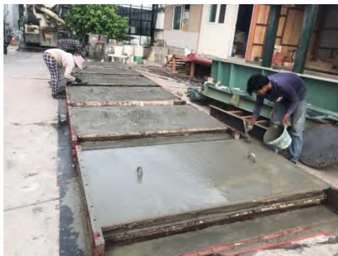
รูปที่ 3.1-13 การก่อสร้างแท่นคอนกรีตไม่ได้เสริมแผ่นยางกันกระแทก
