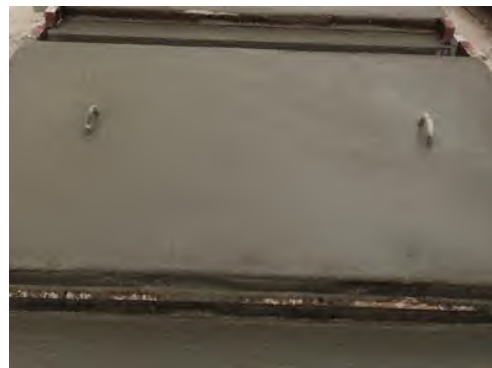
รูปที่ 3.1-13 การก่อสร้างแท่นคอนกรีตไม่ได้เสริมแผ่นยางกันกระแทก
