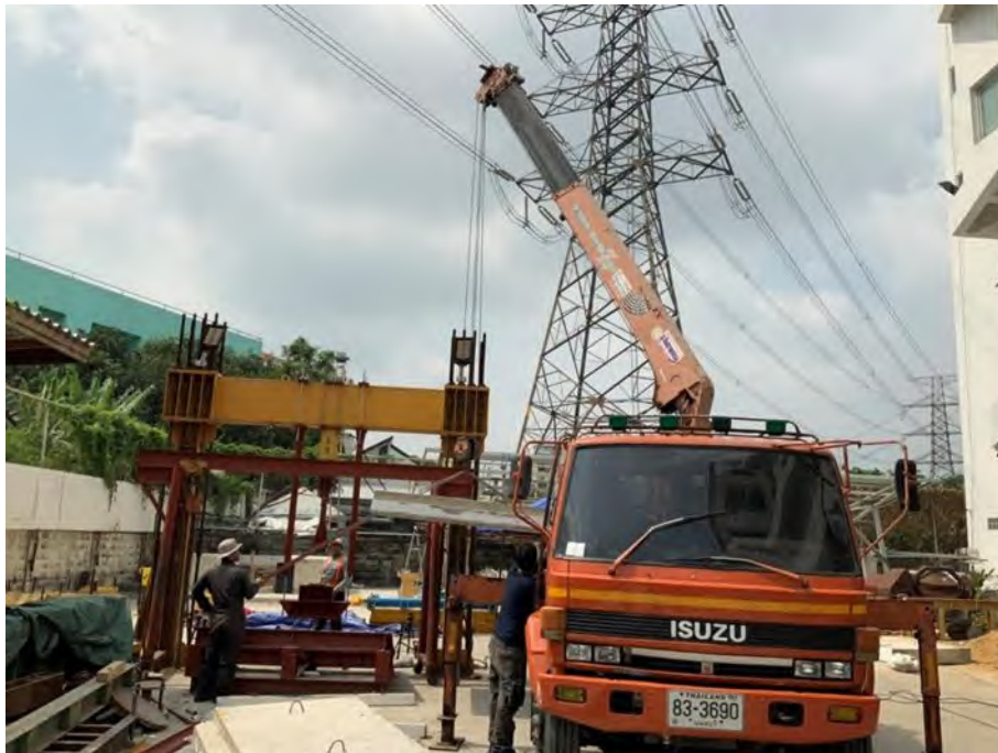
รูปที่ 3.1-23 การติดตั้งบ่ารองรับรอยต่อพื้นสะพานตัวอย่างในโครงเหล็กบนฐานรองรับสำหรับการทดสอบ
