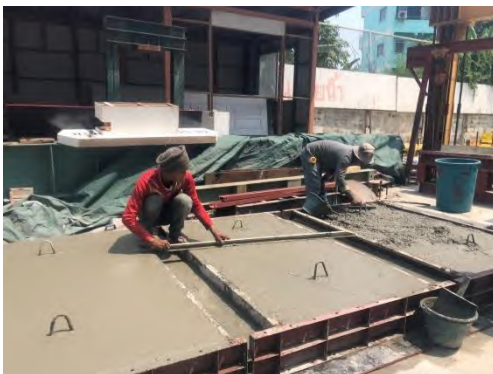
รูปที่ 3.1-14 การก่อสร้างแทนคอนกรีตเสริมแผ่นยางกันกระแทก
