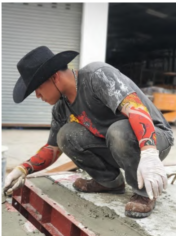
รูปที่ 3.1-17 การหล่อของบ่ารองรับรอยต่อพื้นสะพานเสริมแผ่นยางกันกระแทก
