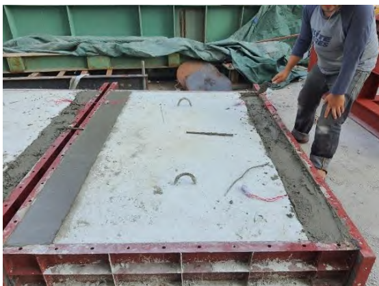
รูปที่ 3.1-16 การหล่อของบ่ารองรับรอยต่อพื้นสะพานไม่ได้เสริมแผ่นยางกันกระแทก
