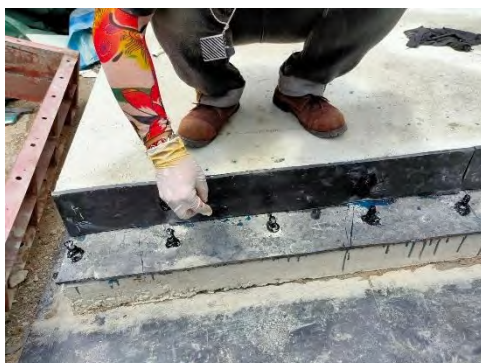
รูปที่ 3.1-15 การติดตั้งแผ่นยางพารา กันกระแทก
