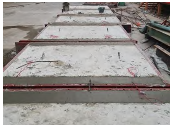
รูปที่ 3.1-16 การหล่อของบ่ารองรับรอยต่อพื้นสะพานไม่ได้เสริมแผ่นยางกันกระแทก
