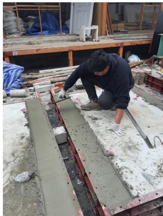
รูปที่ 3.1-17 การหล่อของบ่ารองรับรอยต่อพื้นสะพานเสริมแผ่นยางกันกระแทก
