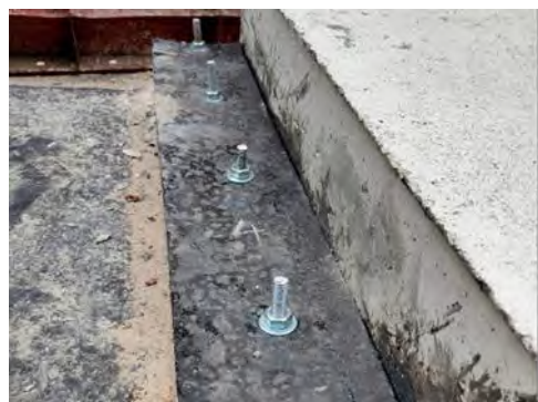
รูปที่ 3.1-15 การติดตั้งแผ่นยางพารา กันกระแทก
