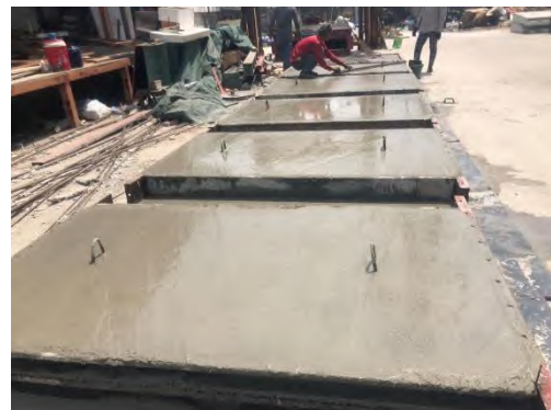
รูปที่ 3.1-14 การก่อสร้างแทนคอนกรีตเสริมแผ่นยางกันกระแทก
